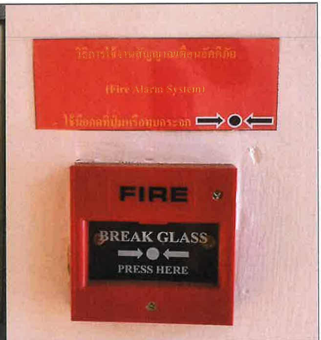
รูปที่ 2.4.7.2-2 อุปกรณ์เตือนภัยโดยมีอกกด(Manual Station)
