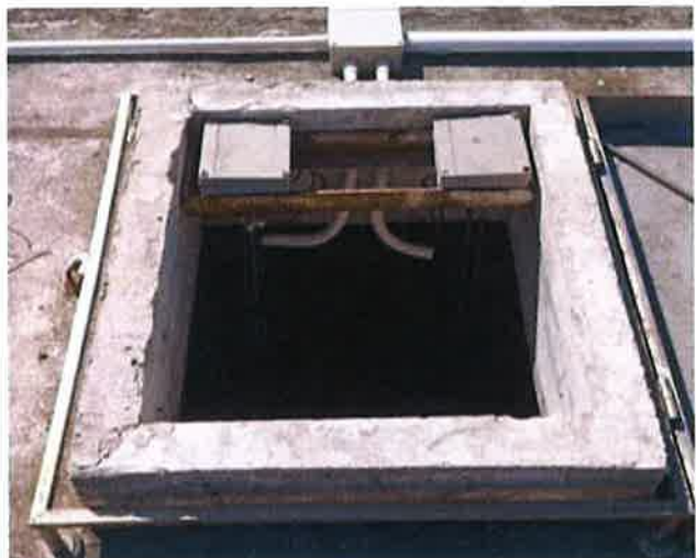
รูปที่ 2.4.1.1-2 ถังเก็บน้ำชั้นดาดฟ้า
